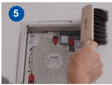
Luftfilter vorsichtig mit einem Handfeger reinigen
