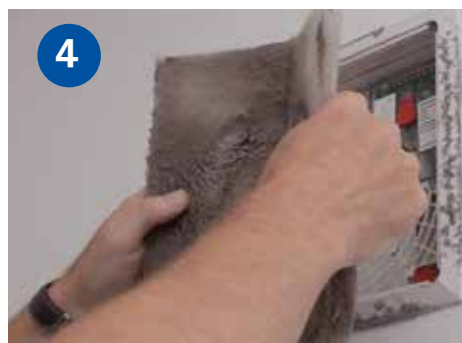
Das alte Vlies entfernen und im Restmüll entsorgen
