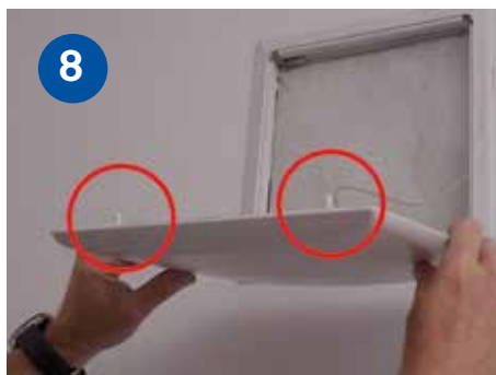
Beide Zapfen mittig ansetzen und die Abdeckung schließen
